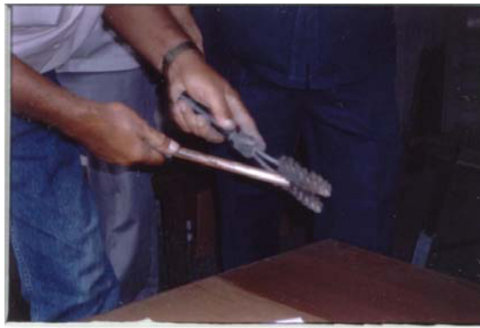
รูปที่ 1.2 ทำความสะอาดหลักดิน
